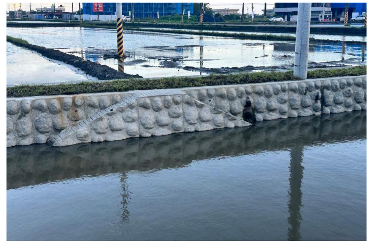
■ 「茅埔排水改善工程」混凝土砌塊石護岸及生物通道
