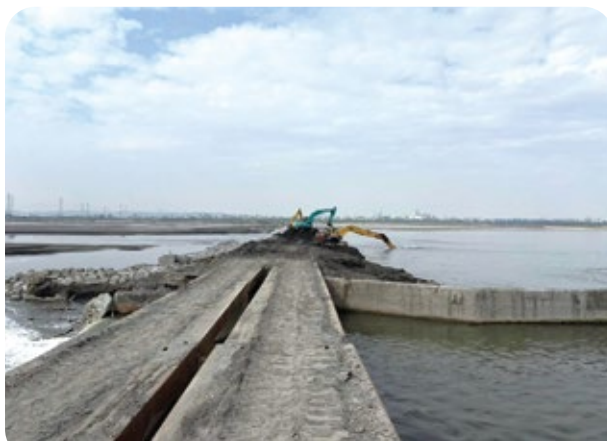
● 本署屏東管理處修繕受災損壞之萬丹圳固床工，施工人員不畏辛勞趕工，使復建工程進度超前
