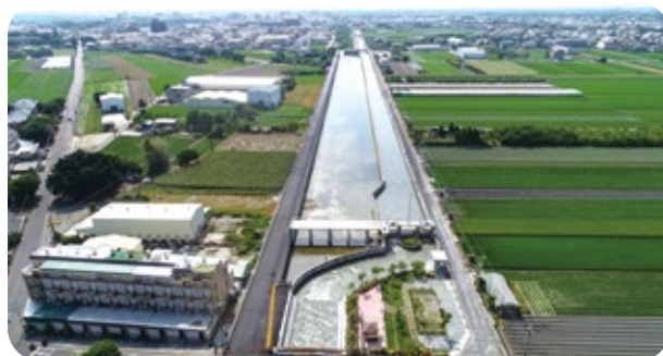
● 濁幹線多功能調蓄池可蓄存夜間離峰水量、補助日間灌溉，有效調節水源供應，並兼具滯洪與沉砂功能，提升系統穩定與灌溉效率。
