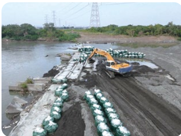
● 本署屏東管理處修繕受災損壞之大陂圳攔河堰，災後立即施工，確保大陂圳灌區供水無虞
