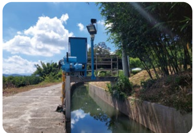
● 本署新竹管理處示範區遠端閘控設備（竹東圳 11 支線）
