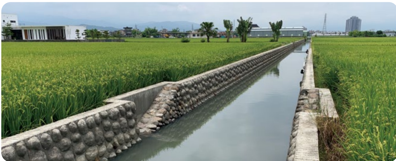
● 增加渠道孔隙率及粗糙度，渠道壁側增設生物友善爬坡
