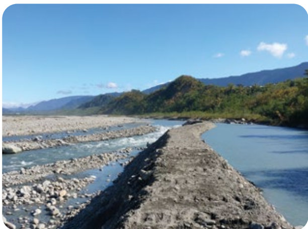
● 本署臺東管理處辦理電光圳搶災工程，確保導水土堤安全流散及進水口設施不受影響，保障電光圳灌區供水無虞
