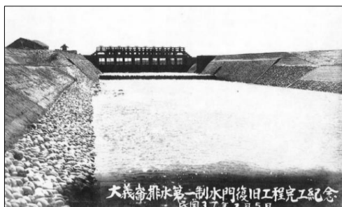
圖 12-13 大義崙排水第一制水閘 (攝於民國 37 年 2 月 5 日)
