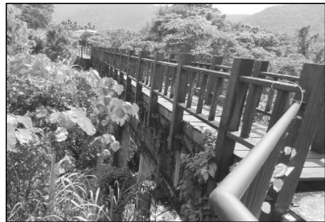
圖 6-4 渡槽上層設木棧道及欄杆 (北圳幹線)
