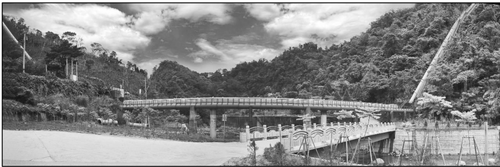
圖 5-3 台中農田水利會白冷圳 2 號倒虹吸工
