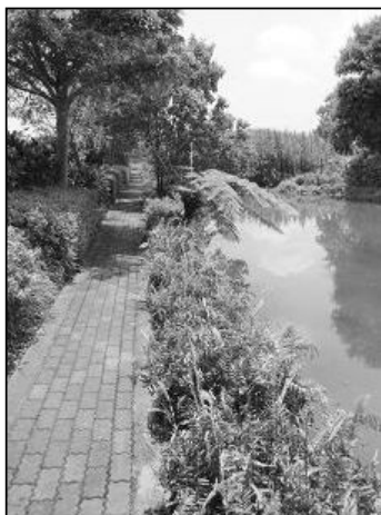
圖 13-4 圳路旁之人行步道以連鎖磚透水鋪面施作
