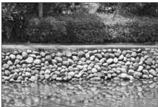
圖 13-6 砌卵石護坡屬多孔隙生態環境
