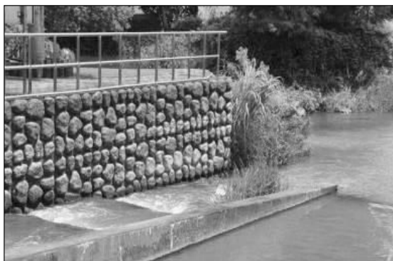
圖 13-7 預鑄式鋼筋混凝土護坡降低碳排
