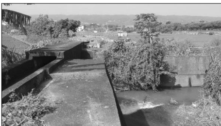
圖 6-7 箱涵渡槽(北投新圳四支線)
