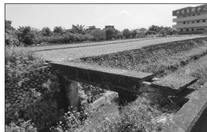
圖 6-8 渡槽加蓋(北投新幹小給)
