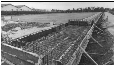
圖 3-9 桃園農田水利會光復圳二支線箱涵施工相片
