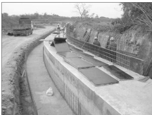
圖 3-11 桃園農田水利會蚵殼港圳排水箱涵施工情形
