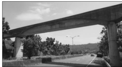
圖 6-6 預力鋼筋混凝土渡槽(龍泉圳)
