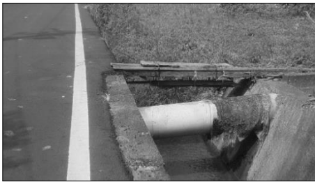
圖 6-5 預製管路渡槽(北投新幹小給)
