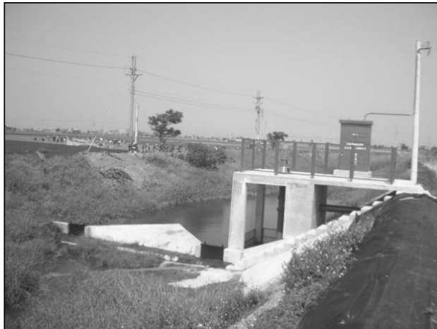
圖 12-24 北水林分線補助水源抽水站
