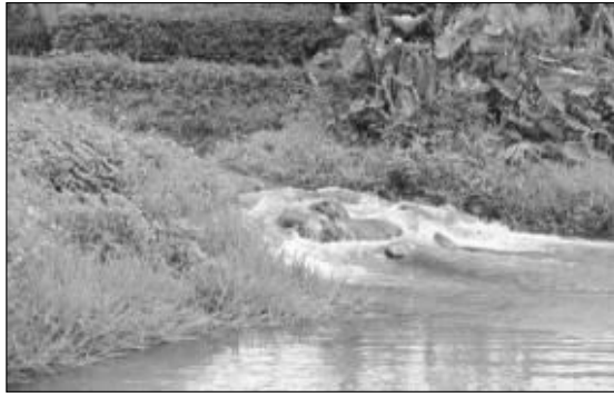
圖 13-13 多孔隙淺灘圳床及拋石工法
