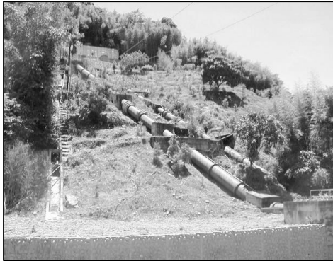
圖 5-2 台中農田水利會白冷圳 1 號倒虹吸工
