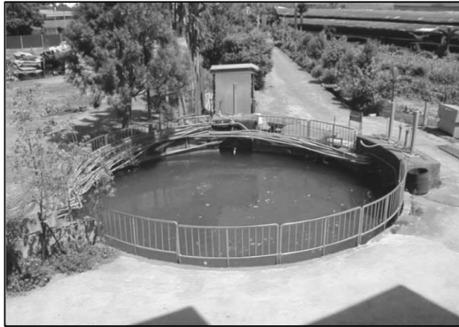
圖 8-11 台中農田水利會白冷圳分水池 1 號池
