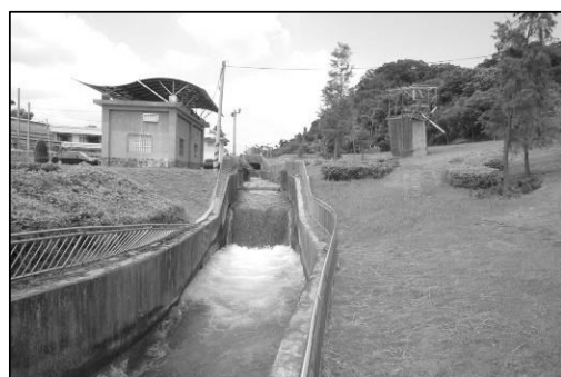
圖 4-20 台中農田水利會葫蘆墩圳跌水工
