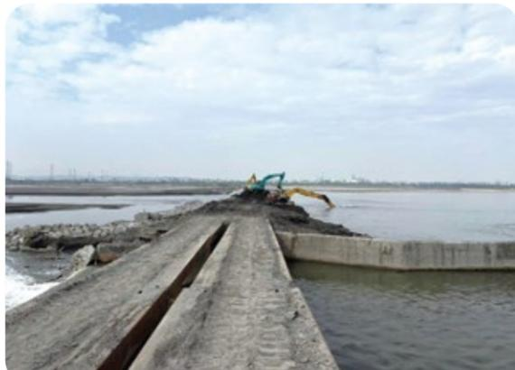
● 本署屏東管理處修繕受災損壞之萬丹圳固床工，施工人員不畏辛勞趕工，使復建工程進度超前
