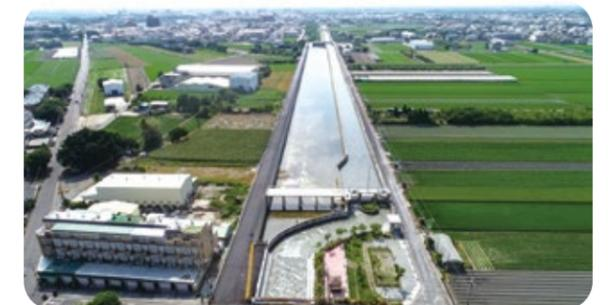
● 濁幹線多功能調蓄池可蓄存夜間離峰水量、補助日間灌溉，有效調節水源供應，並兼具滯洪與沉砂功能，提升系統穩定與灌溉效率。
