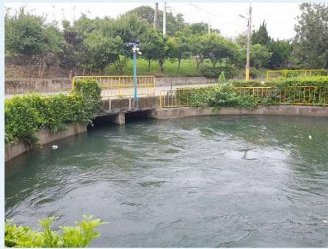
這兩個孔洞的水是從舊港圳自動倒伏水門流過來的。
