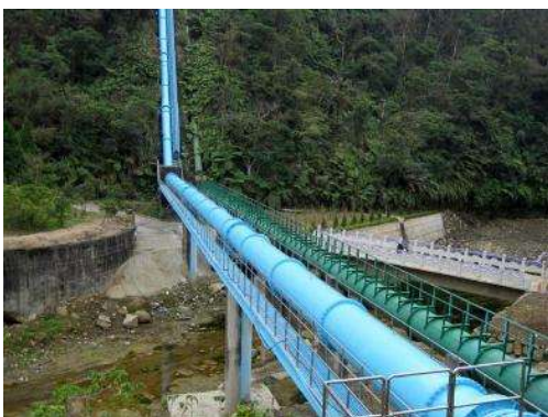
照片 2 圖右為日治時期所建之歷史建物， 圖左為 921 地震後新用之倒虹吸管
