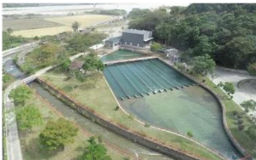
台東水利會-關山圳沉砂池小水力電廠
