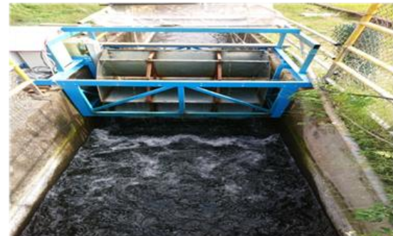
新竹水利會-竹東圳圳路型微水力發電站
