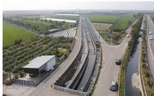
彰化水利會-北岸聯絡渠(渠道型、施工中)
